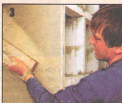
В заключение готовый стеллаж окрашивают в тон отделки стен комнаты.
