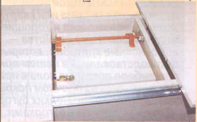
Схема 4. Варианты крепления направляющих: сверху и сбоку царги (внутри или снаружи).
