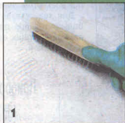
Выступы на цементной стяжке удаляют, после чего пыль с поверхности тщательно убирают пылесосом.
