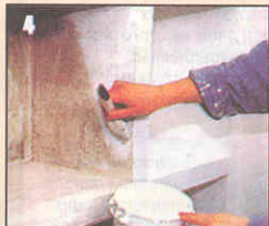
Когда раствор (клей) полностью застынет, стыки между блоками и поверхность стеллажа шпателью. Штукатурить их не надо.
