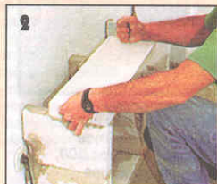
Когда раствор (клей) полностью застынет, стыки между блоками и поверхность стеллажа шпателью. Штукатурить их не надо.
