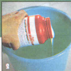
Концентрированный глубокопроникающий грунт разводят водой непосредственно на месте.
